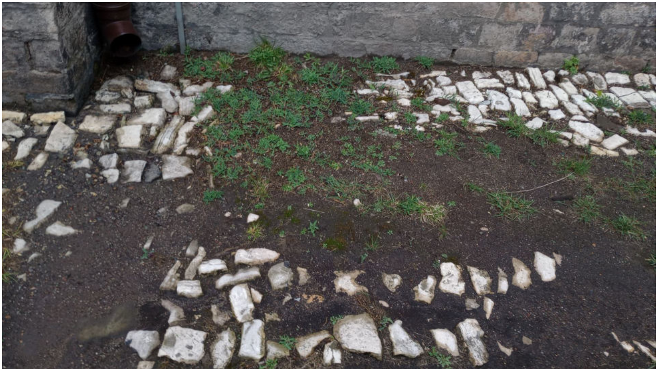
Fot 6: Fragment bruku przy południowej fasadzie kościoła (widoczna rura spustowa przy wieży południowej).
