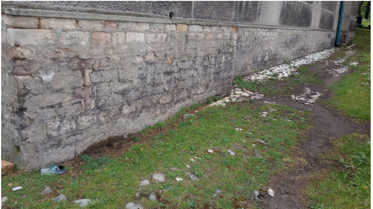
Fot 5: Bruk wzdłuż fasady południowej kościoła.
