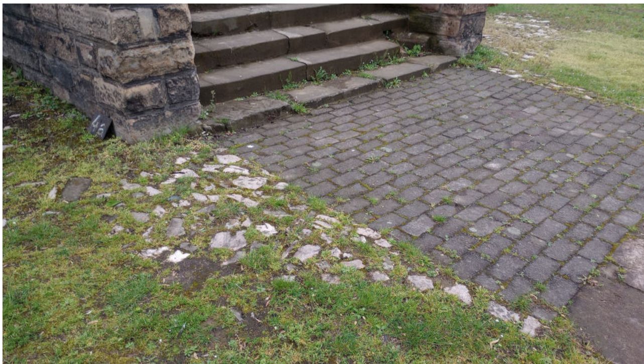
Fot 3: Bruk i betonowa kostka przed schodami wejściowymi do kościoła.
