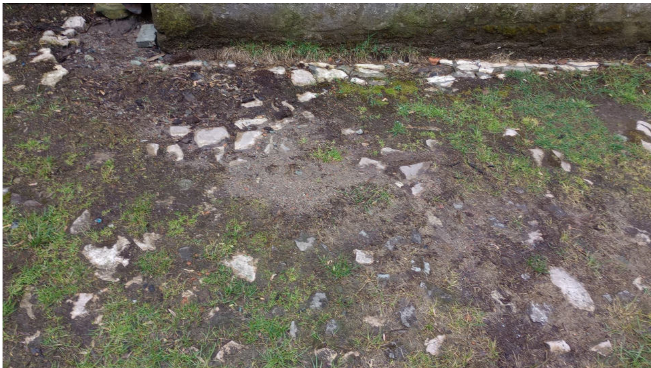
Fot 12: Fragment bruku przy północnej fasadzie kościoła (przy wieży północnej).
