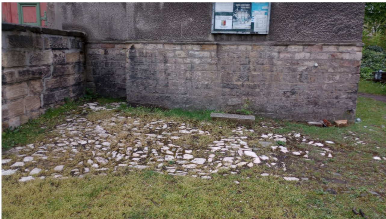
Fot 4: Fragment bruku przed fasadą główną (narożnik południowo- zachodni kościoła).
