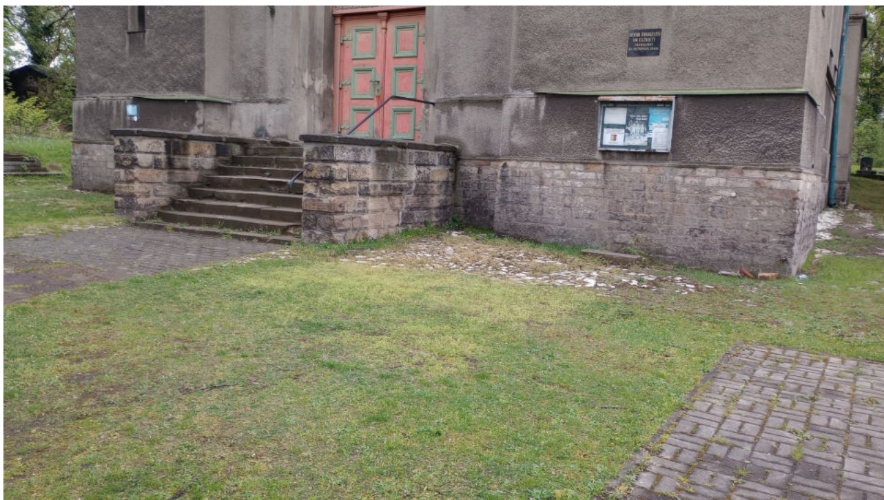
Fot 1: Bruk przed fasadą główną (zachodnią).
